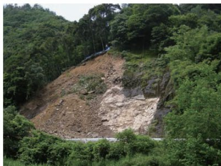
崩壊現場全景
