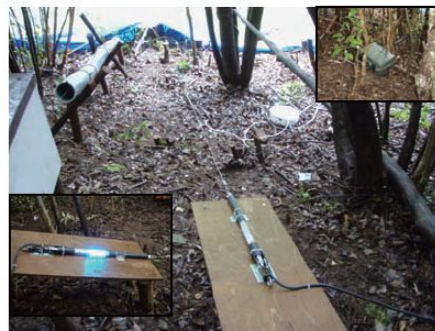
光る変位計設置
