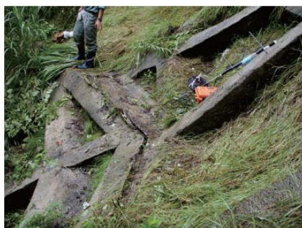
光る変位計設置
