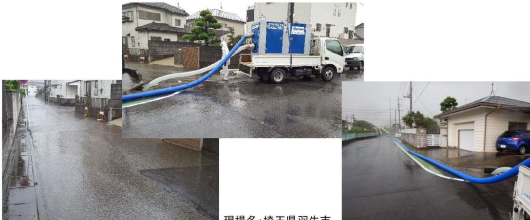
現場名：埼玉県羽生市
