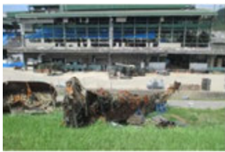
爆発した工場と高梁川の堤防に飛散した設備
