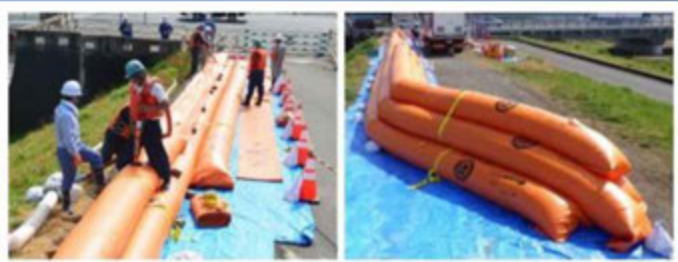
図-12 給水状況(2本同時給水)と完成風景(3段屈曲積み)
