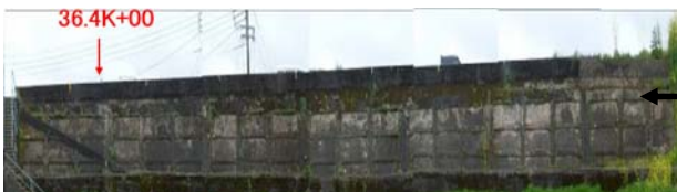
可視画像（河川堤防法枠部での実施例）
