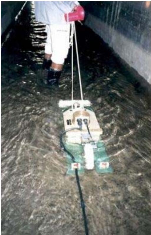
弊社探査システム（函内から探査できる）
