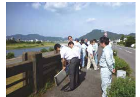
長良川畳堤へのハイブリッドパネル設置確認
