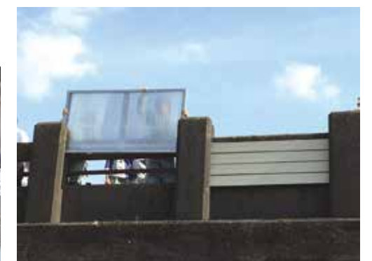
堤内地と堤外地との出入口への適用
