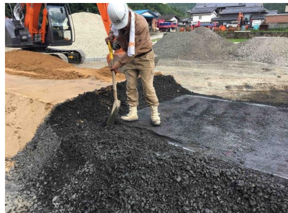
図 1.17 左:振動ローラによる転圧 右:プリーザブルシート取り出し
