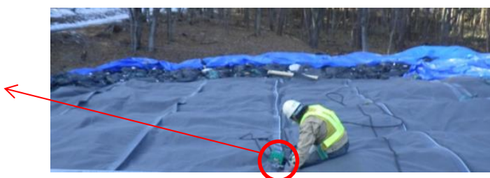
図 2.9 熱融着接合状況(現場施工)
