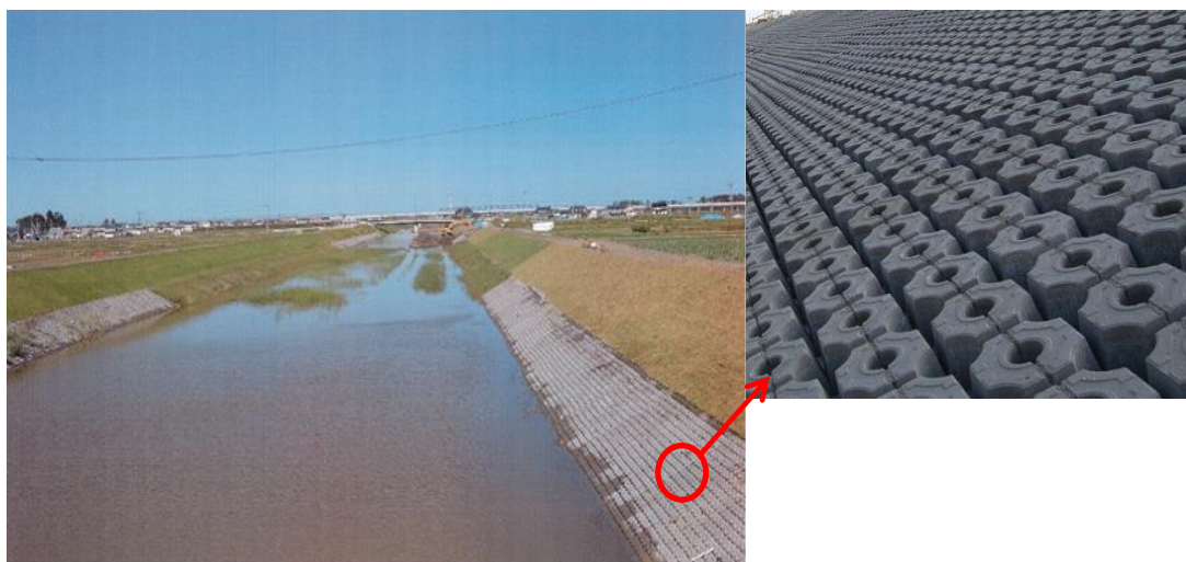
図 2.4 ブロックマットによる保護工の事例
