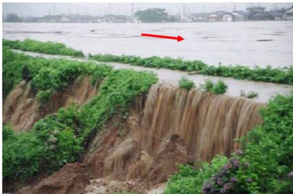
図 2.1.2 群 2/3 越水による破堤の事例 (H16年7月新潟・福島豪雨 五十嵐川)
