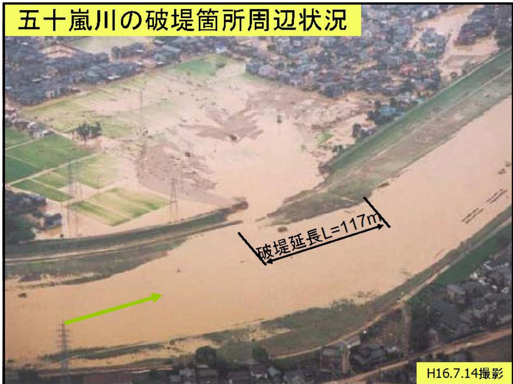
図 2.1.2 群 3/3 越水による破堤の事例 (H16年7月新潟・福島豪雨 五十嵐川)
