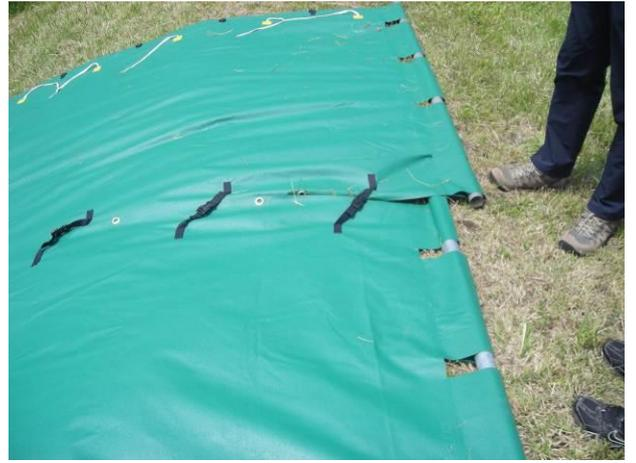
天端、単管パイプ挿入状況。若干のシートのずれは接続に影響なし
