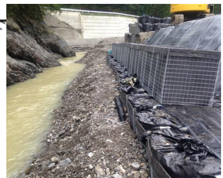
図-2.3.5 マックスウォールに内袋を入れて中詰め材を封入した事例
