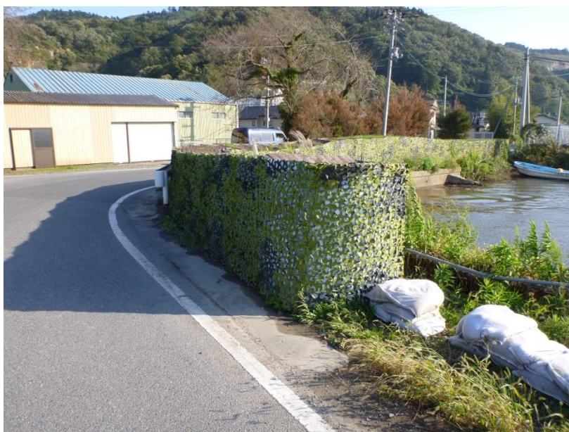
写真-4.1.1 緑化ネットで被覆したマックスウォール工法
