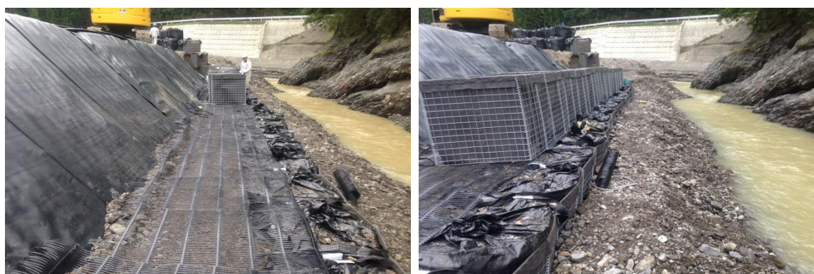
写真-5.6.3 法面の補強と安定性をはかるためにジオグリッドを敷設した事例
