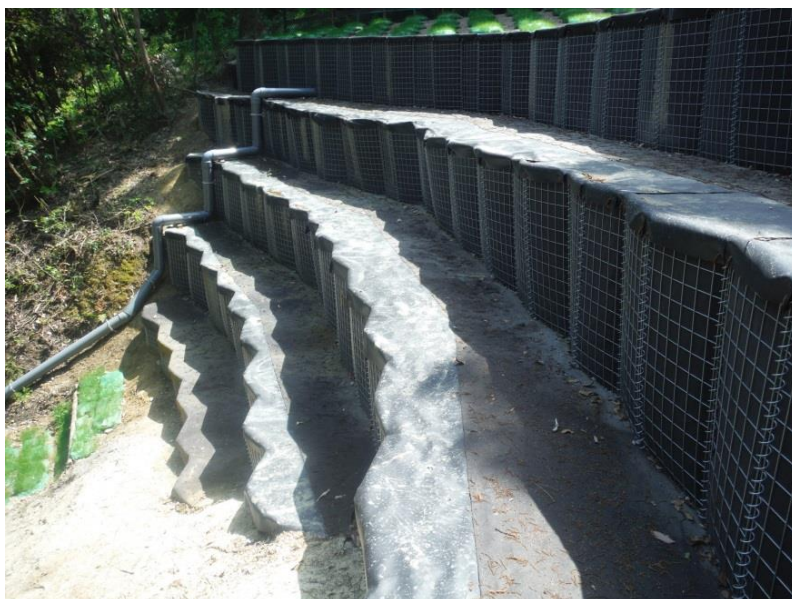
図-5. 6. 3 縦断勾配を有する場合の天端処理の事例
