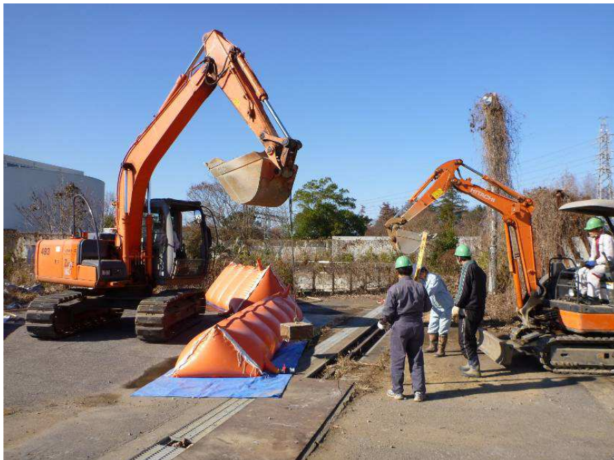
写真 II-20 耐衝撃性確認試験の状況
