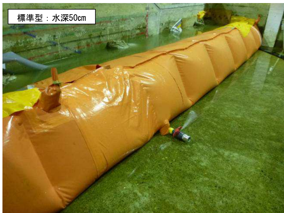
写真 II-18 設計水深時の止水（漏水）状況（標準型）
