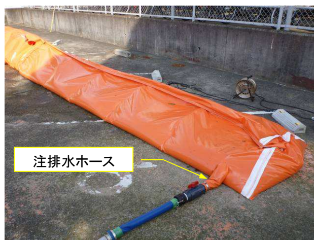
写真 II-7 注排水ホース（消防ホース接続状況）
