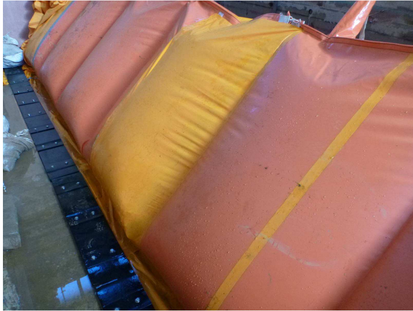
写真 II-15 セルフシール浮き上がり防止用重し（押さえゴム板）
