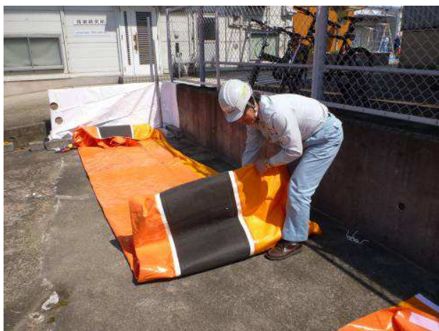
写真 II-41 『三角水のう』（標準型）の敷設・注水状況
