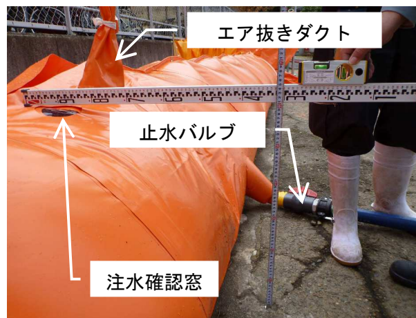
写真 II-4 三角水のう注排水構成
