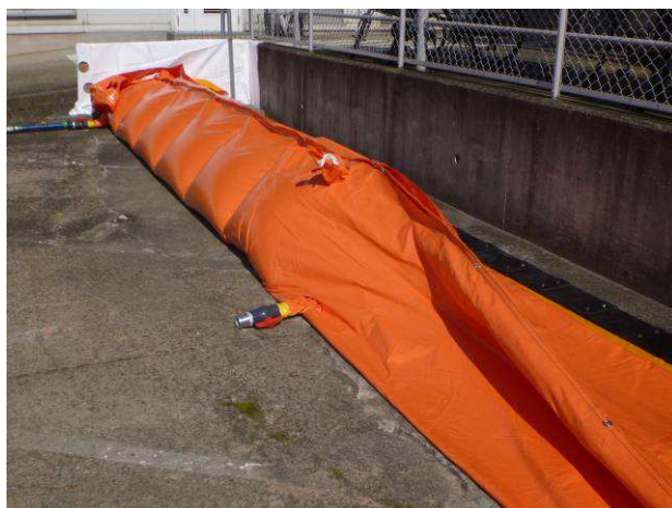
写真 II-41 『三角水のう』（標準型）の敷設・注水状況
