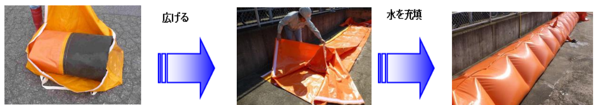
図 4.7 三角水のうの設置手順
