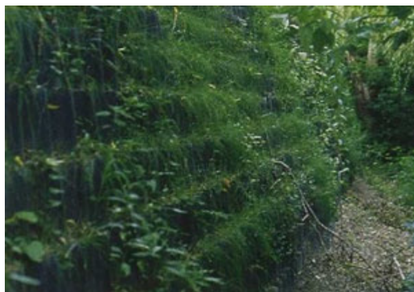
写真-5.1 多段積みしたときの緑化の状況
