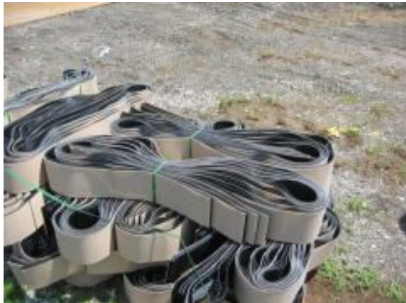
写真-2.1 搬入されたジオセル
