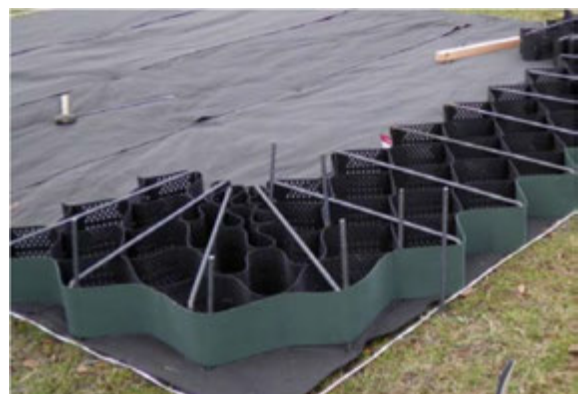
写真-2.4 曲線部における設置
