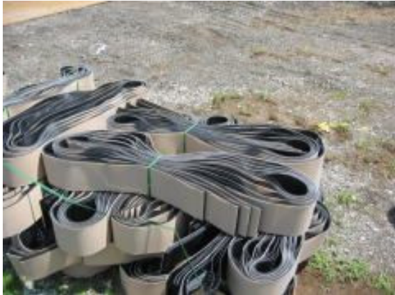
写真-2.1 搬入されたジオセル
