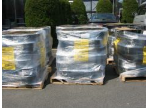
写真-2.2 ジオセルの保管状況
